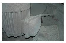
Ventilator im Abluftsystem mit schlechter Abluftfiltrierung. Der Wirkungsgrad nimmt stark ab, so dass für die gleiche Absaugleistungen wesentlich mehr Energieaufwand notwendig ist. Das Brandrisiko nimmt ebenfalls erheblich zu.
